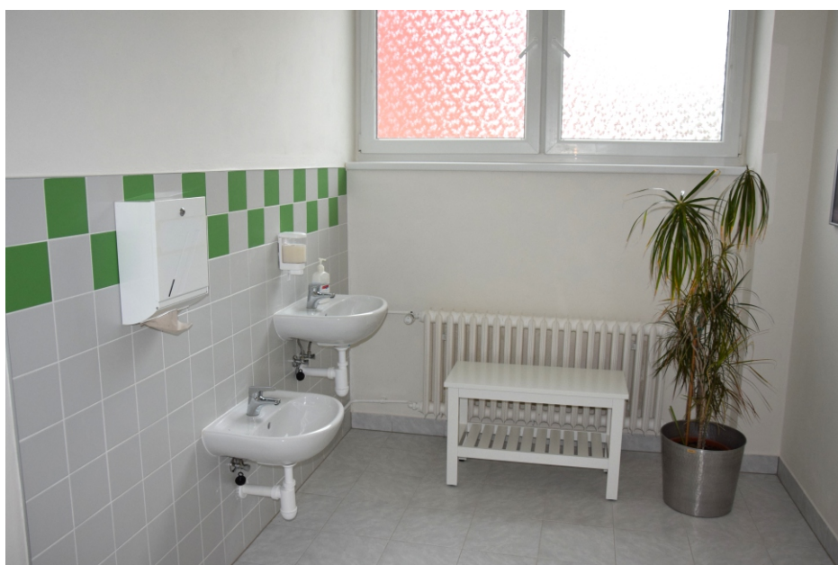
zrekonstruované sociální zázemí na odloučeném pracovišti (Palackého tř. 146)
